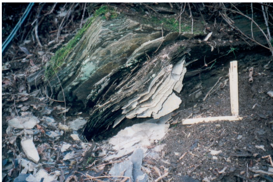
Abb. 1: Der an einer Einschnittböschung der ehemaligen Bahntrasse, die am Südhang des Burgberges von Burg Lichtenberg entlangführt, anstehende Papierschiefer. An der Südseite des genannten Burgberges sind unter einem Lagergang aus „Kuselit“ (= ein aus einer speziellen Gesteinsschmelze in der Erdkruste zur Erstarrung gelangtes Intrusivgestein) Lebacher Schichten mit diesem Papierschieferbänkchen aufgeschlossen. Oberhalb dieser Stelle mit dem zu einem Papierschiefer verwitterten fein geschichteten, bituminösen Tonsteinbänkchen tritt am Hang des Burgberges immer wieder verstärkt Grundwasser aus.
