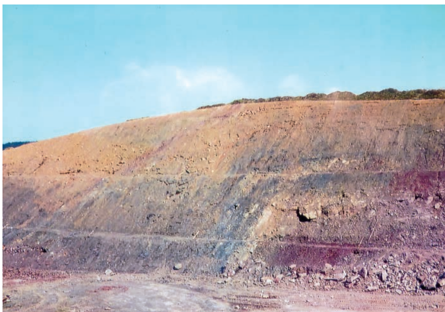
Abb. 3: Ansicht eines Teilbereiches von der nördlichen Ostwand dieses Geländeeinschnittes, die mit einem Schleier verschleiften Gesteinsmaterials überzogen ist. Als dieses aus dem Jahre 1969 stammende Foto angefertigt wurde, hatten die Erdarbeiten das Abbaufeld einer ehemaligen Kohlengrube noch nicht erreicht. Die Rotfärbung eines Teiles der anstehenden Sedimentgesteine (Keine Rothorizonte! Keine Rotsedimente!) kam durch den Einfluss von einsickerndem Oberflächenwasser in den Schichtenkomplex zustande.
