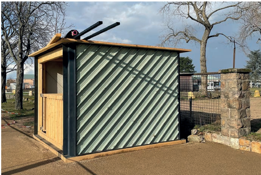
Abb. 2: Ein Häuschen aus Dachpaneelen.
